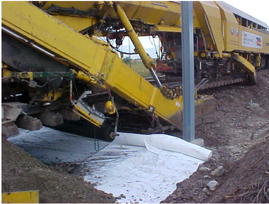
Figura. 26: Așternerea geosinteticelor cu tren de lucru
