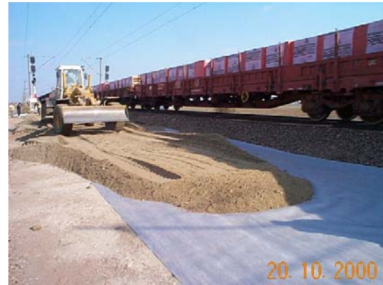
Figura 2: Așternerea geotextilului TYPAR SF77 și a substratului căii
