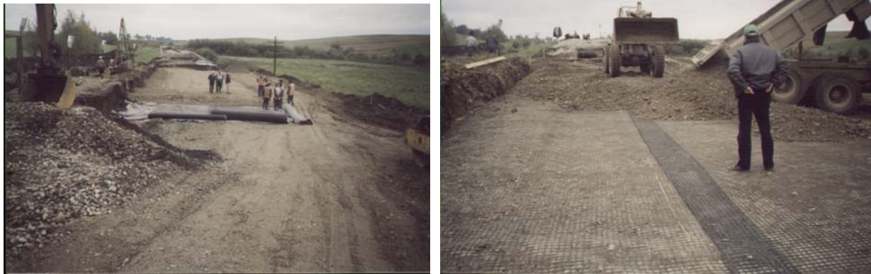
Figura 11: Așternerea geogridurilor în baza decapării și a materialului de umplură
