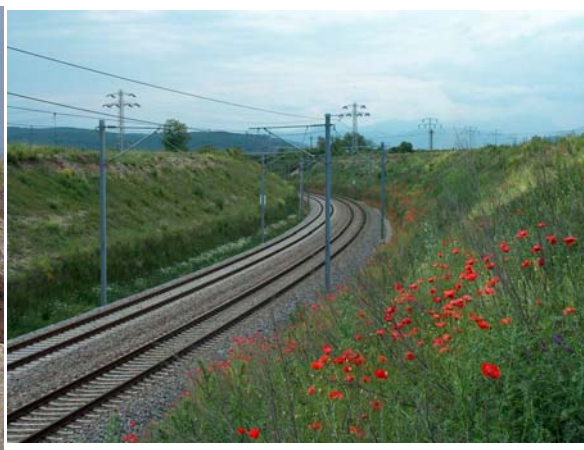
Figura.23: Taluze abrupte armate km 86+900 - 87+400 iunie 2004
