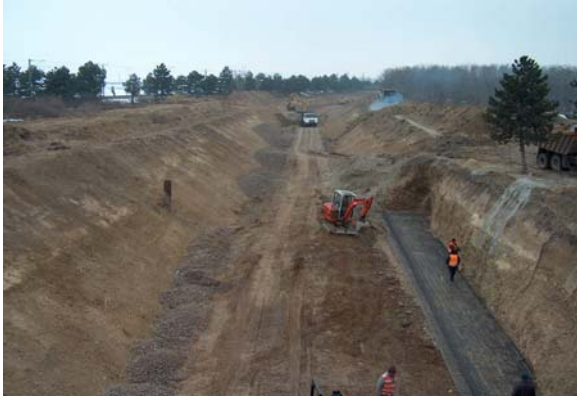
Figura 18: Zid debleu km 57+400– februarie 2003
