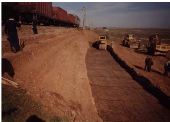
Figura 15: Așternerea geogridurilor în baza decapării și a materialului de umplură
