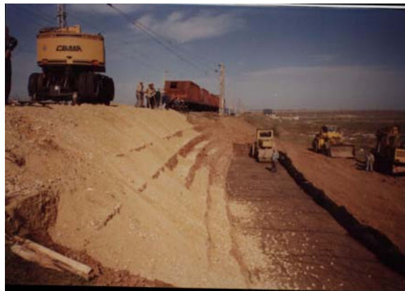
Figura 15: Așternerea geogridurilor în baza decapării și a materialului de umplură
