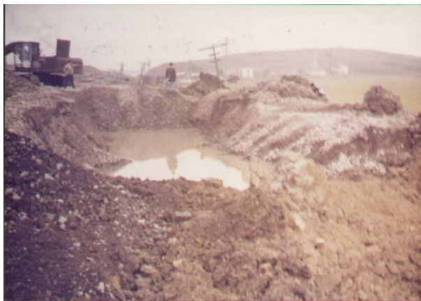
Figura 3: Nivelul ridicat al apei freatice
