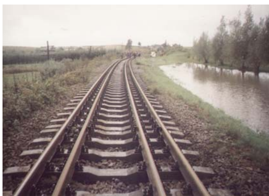
Figura 8: Tasarea rambleului liniei încălecate
