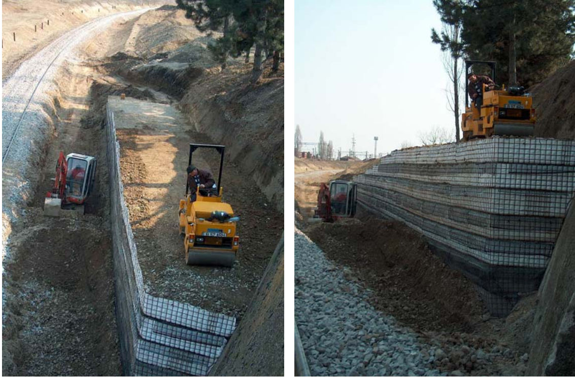
Figura 16: Zid debleu în execuție km 57+280 – martie 2003
