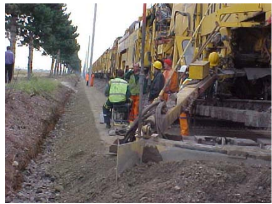
Figura 27: Realizarea stratului portant armat
