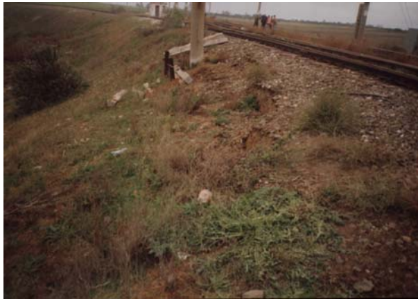
Figura 12: Alunecarea rambleului liniei ferry-boat
