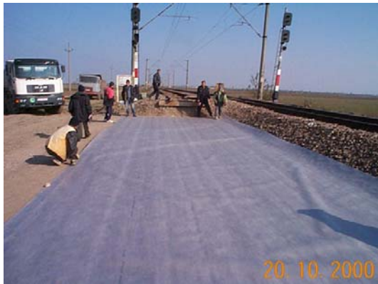
Figura 2: Așternerea geotextilului TYPAR SF77 și a substratului căii
