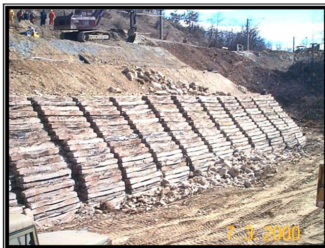
Figura 7: Vedere parament din traverse de beton recuperate
