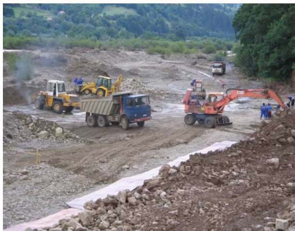
Figura 29: Vederea geotextilului în baza rambleului
