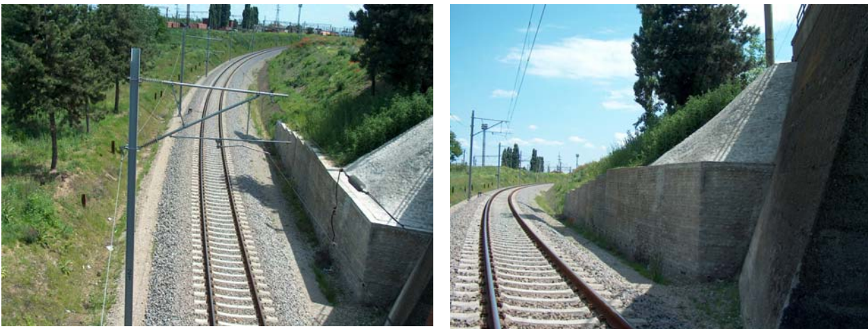
Figura 17: Zid debleu finalizat km 57+280 – iunie 2004
