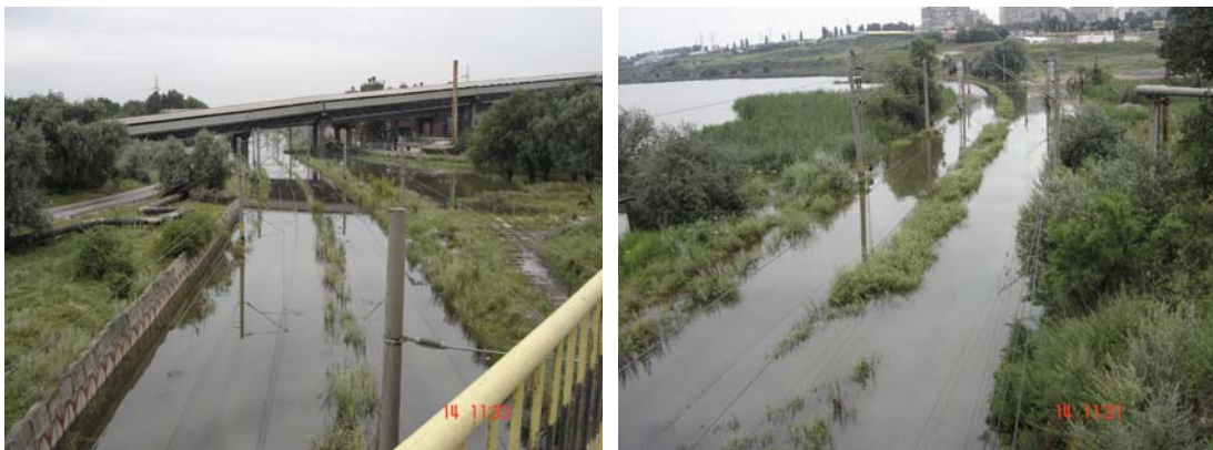
Figura 31: Inundarea liniei c.f. de apele lacului Cătușa
