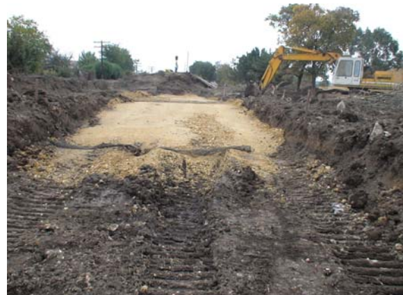
Figura 39: Așternerea geosinteticelor
